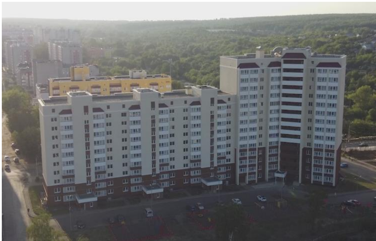
Рис. 8. «Дом многоэтажной жилой застройки (площадка № 1 по генплану) в квартале, ограниченном улицами Гагарина, Фурманова, Филатова, Мичурина в г. Саранске» (1 и 2 этапы строительства)
