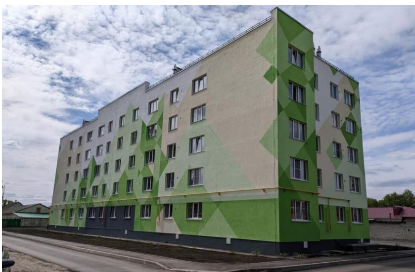
Рис. 14. «Многоквартирный жилой дом в г. Ковылкино»
